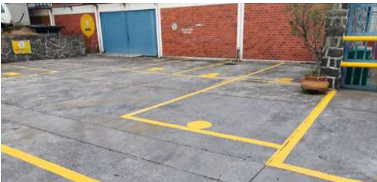
■ APLICACIÓN de pintura de líneas de estacionamiento.
