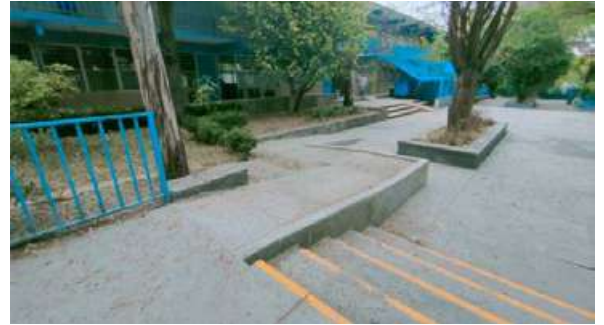
■ CONSTRUCCIÓN de rampas de acceso.
