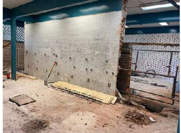
■ REMODELACIÓN de núcleo sanitario.
