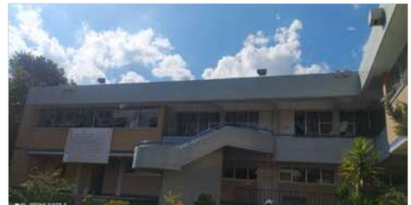
■ APLICACIÓN de pintura en edificios del Siladin.
