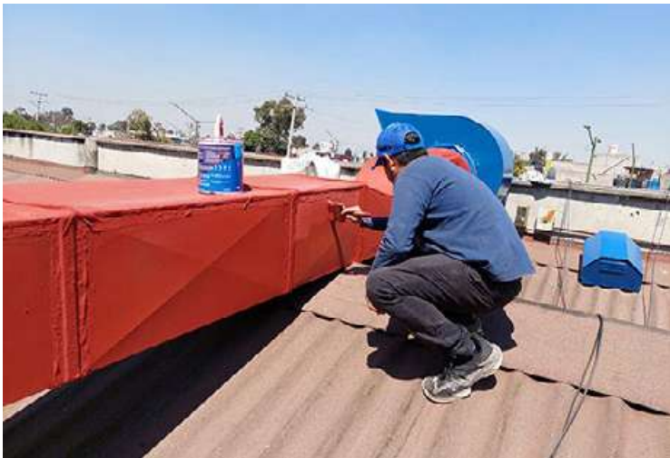
■ MANTENIMIENTO a sistemas de aire acondicionado.
