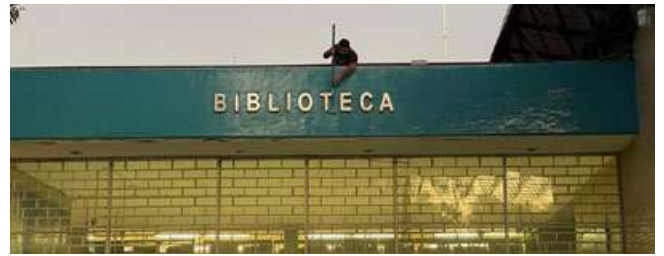
■ RETOQUE de pintura en fachada y cubo de escaleras en biblioteca.
