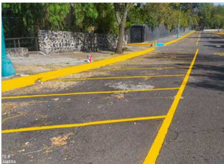
■ RECONDICIONAMIENTO de cubículos de Psicopedagogía.
