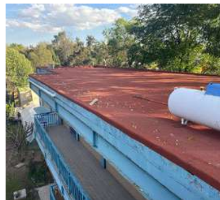
■ MANTENIMIENTO de azoteas y cambio de membrana impermeabilizante.
