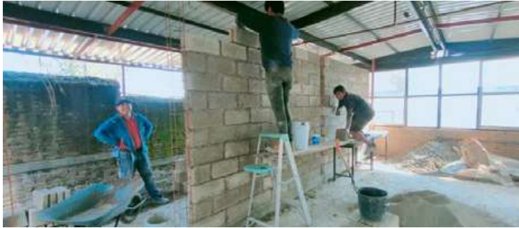
■ EDIFICACIÓN de bodega en invernadero.
