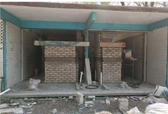
■ READECUACIÓN de baños y vestidores en edificio H.
