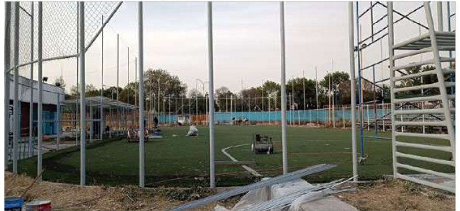
■ SUMINISTRO y colocación de tablas plásticas para cancha de futbol rápido.
