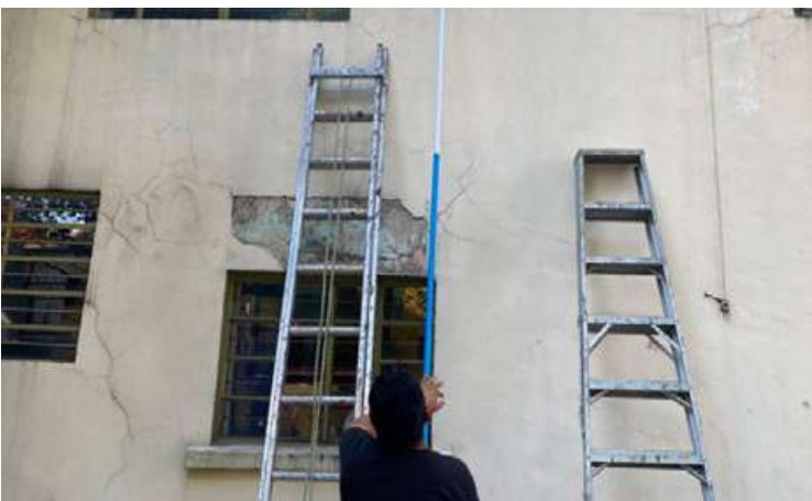
■ ARREGLOS en fachada de imprenta.
