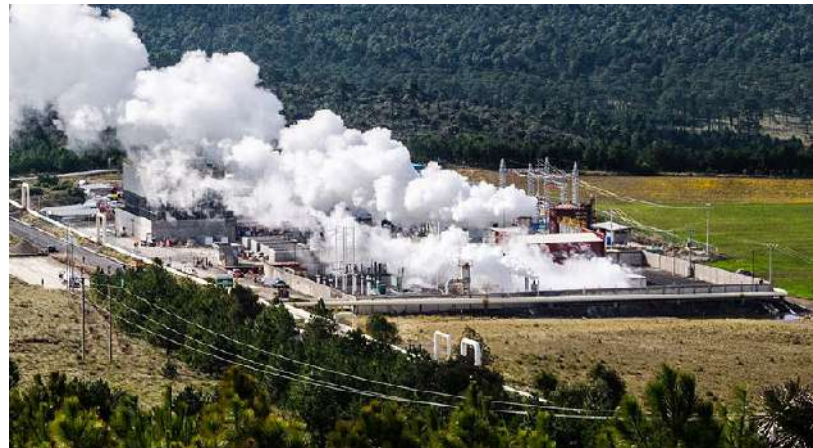
■ PLANTA geotermoeléctrica Los azufres.
