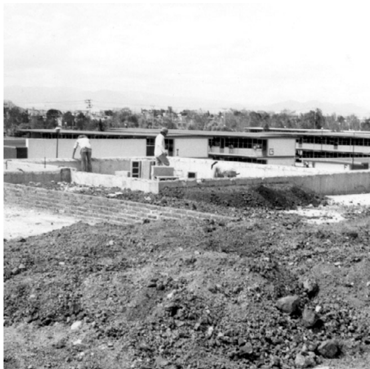
Edificios del plantel Vallejo en plena construcción.
