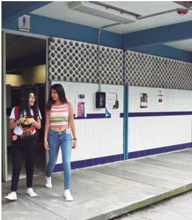
Núcleos sanitarios en el edificio “L”.
