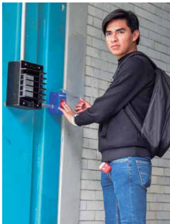
Botón de emergencia en el edificio de Mediateca.
