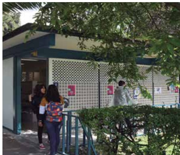
Núcleos sanitarios en el edificio de Servicios Escolares.
