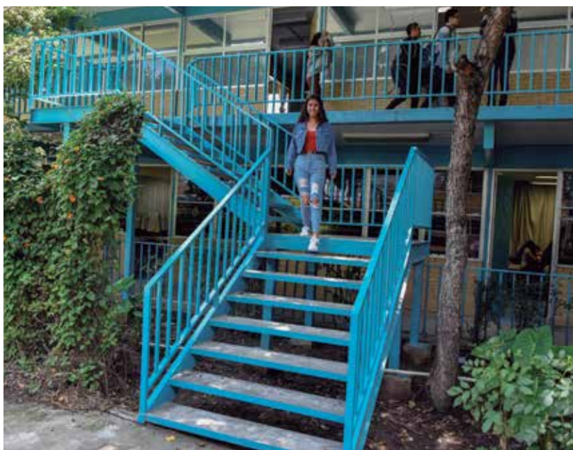
Escaleras en el edificio “O”.
